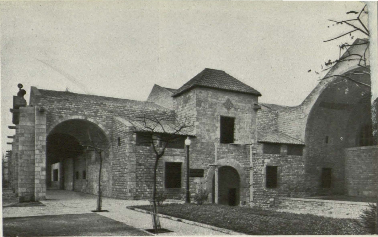
Fachada de ingreso. La puerta, que se ensanchó desmesuradamente para dar paso a piezas y arzones de artillería, será reducida a su dimensión original.
